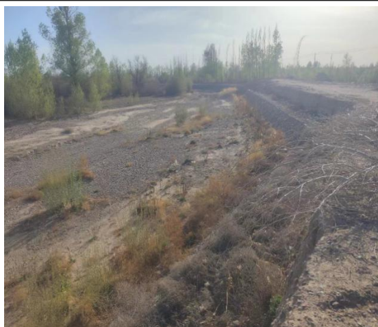
治理下段护岸起点
