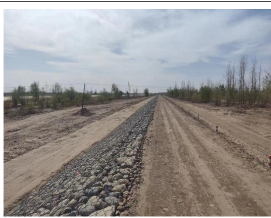
治理上段堤防工程
