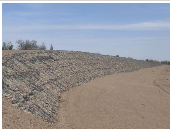
治理上段堤防工程起点
